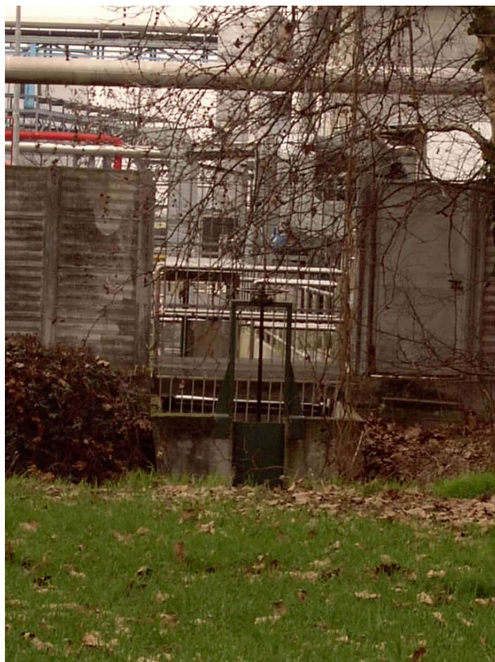
Ingresso di monte della roggia Rino all'interno dell'area della ditta Bidachem. Visibile la totale artificializzazione dell'alveo della roggia.
