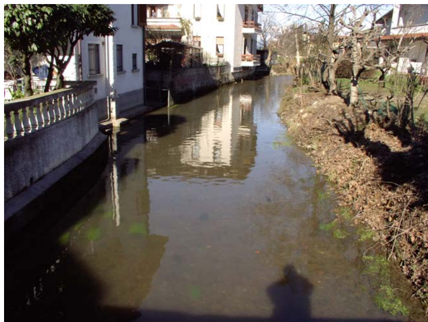
Roggia Orso a monte dell'antico ponte in corrispondenza dell'abitato. Si noti il peggioramento qualitativo delle acque rispetto al tratto sopra.
