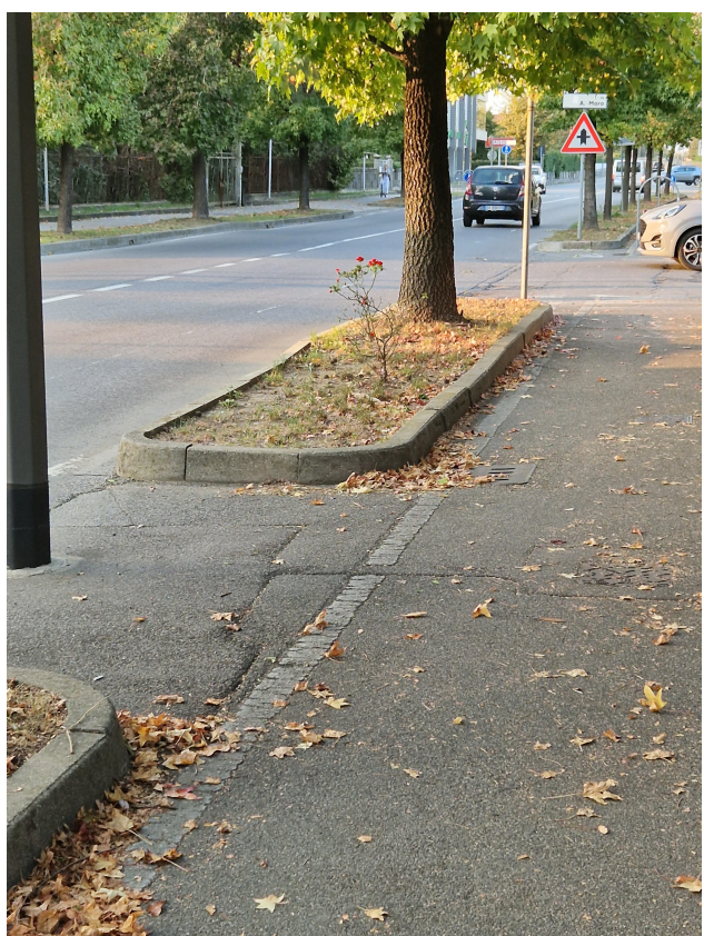
TRATTO DI COLLEGAMENTO DI VIA MORO ALL'ATTRAVERSAMENTO DI VIA LOCATELLI
