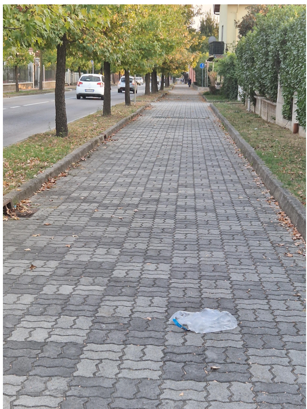
PAVIMENTAZIONE IN AUTOBLOCCANTI IN BUONO STATO DI COMPLANARITA' SU TUTTO IL PERCORSO
