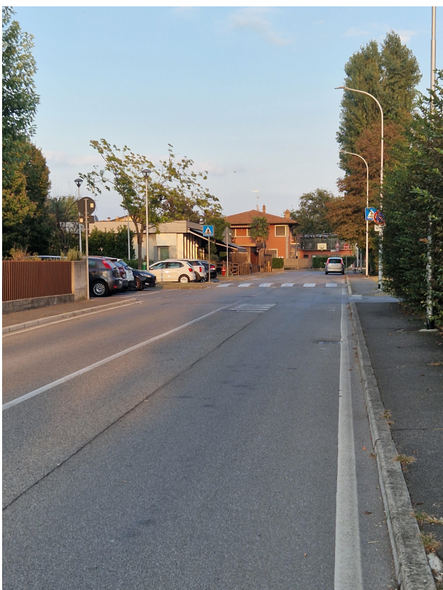
VIA ALDO MORO: IL PERCORSO E' DA REALIZZARE IN PROMISCO CON LA CARREGGIATA STRADALE
