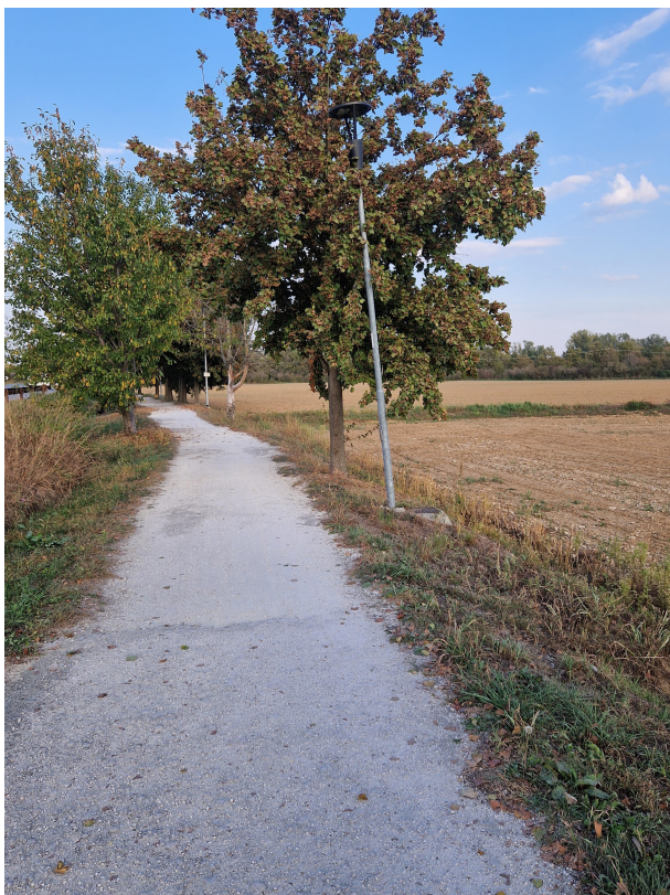
PALI LUCE IN POSIZIONE PRECARIA E/O ELEMENTI ILLUMINANTI COPERTI DAI RAMI
