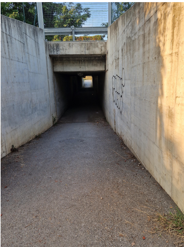
SOTTOPASSO AL SP 130 E ALLA FERROVIA
