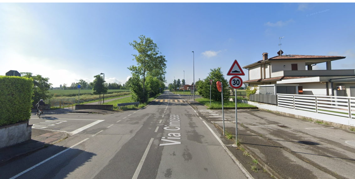
IMBOCCO DELLA CICLABILE ESISTENTE (a sinistra)
