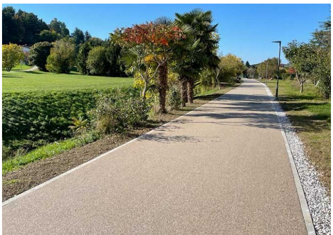
ESEMPIO CICLABILE PER PARTI ESTERNE ALL'URBANIZZATO: conglomerato colorato con legante ecologico
