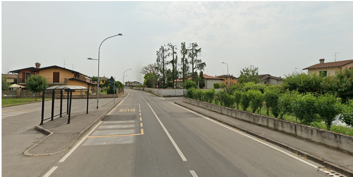
REALIZZAZIONE CICLABILE IN PROMISCUO CON CARREGGIATA DI VIA CIRCONVALLAZIONE
