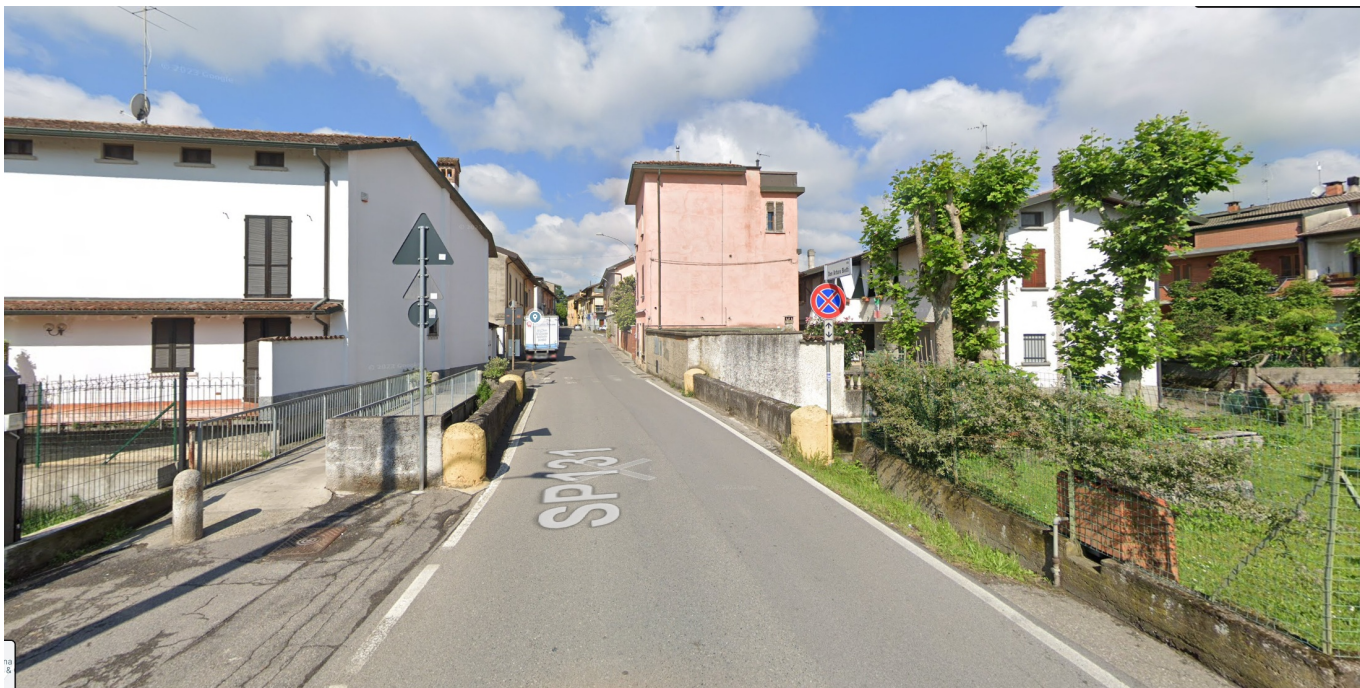
PONTICELLO SU ROGGIA RINO DA RIQUALIFICARE PER IL PERCORSO CICLABILE
