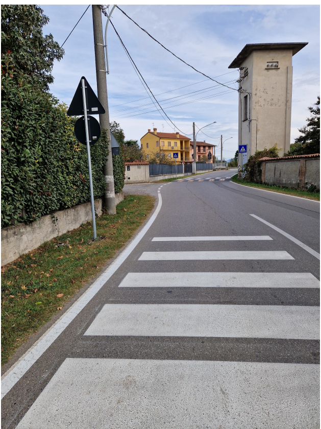
OCCUPAZIONE DELL'AREA DI RESIDUO STRADALE SU AMBO I LATI DELLA STRADA
