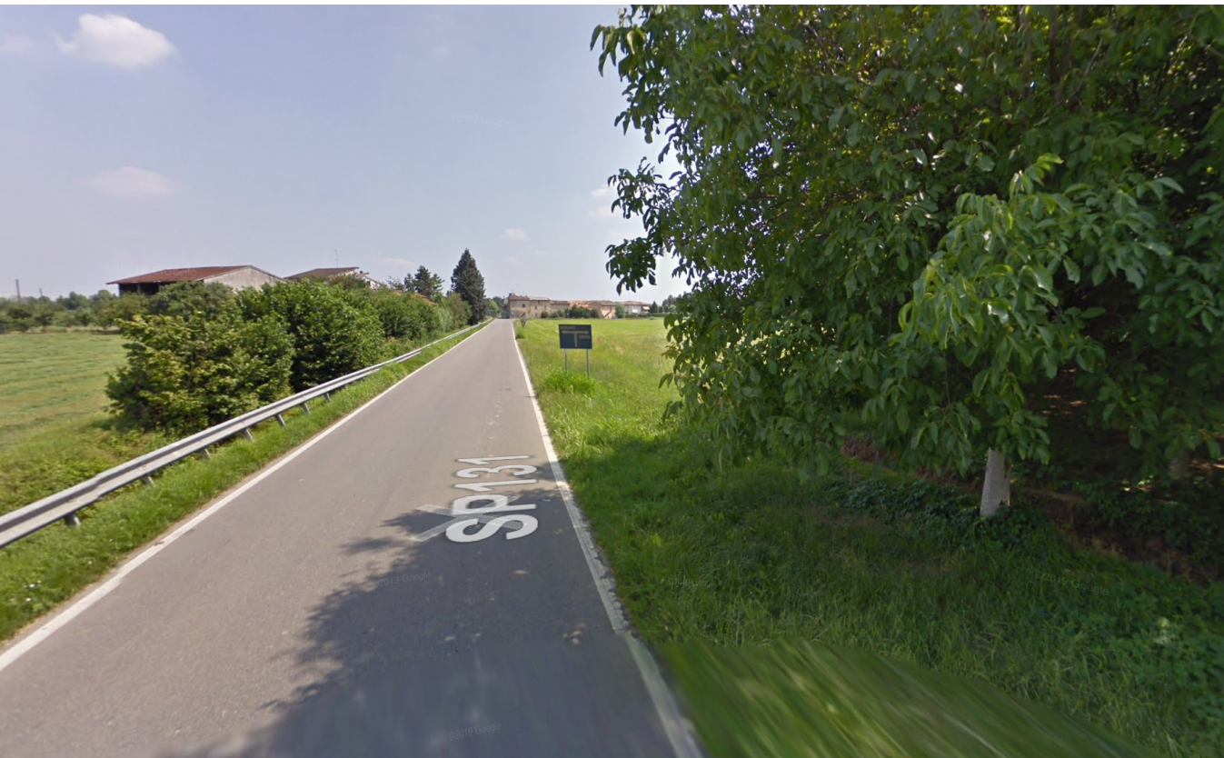
SP131 VERSO LA EX PROVINCIALE VIA BERGAMO: LA CICLABILE OCCUPERA' PARTE DEL SEDIME (in lato sx nella foto) PER LA LARGHEZZA DI m. 2.50
