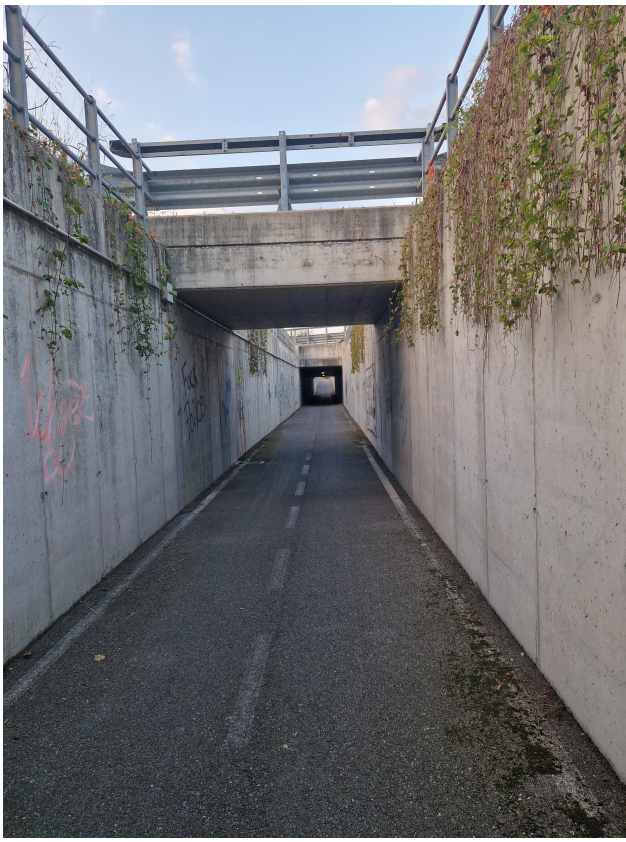
SOTTOPASSO FERROVIARIO E BRE.BE.MI.
