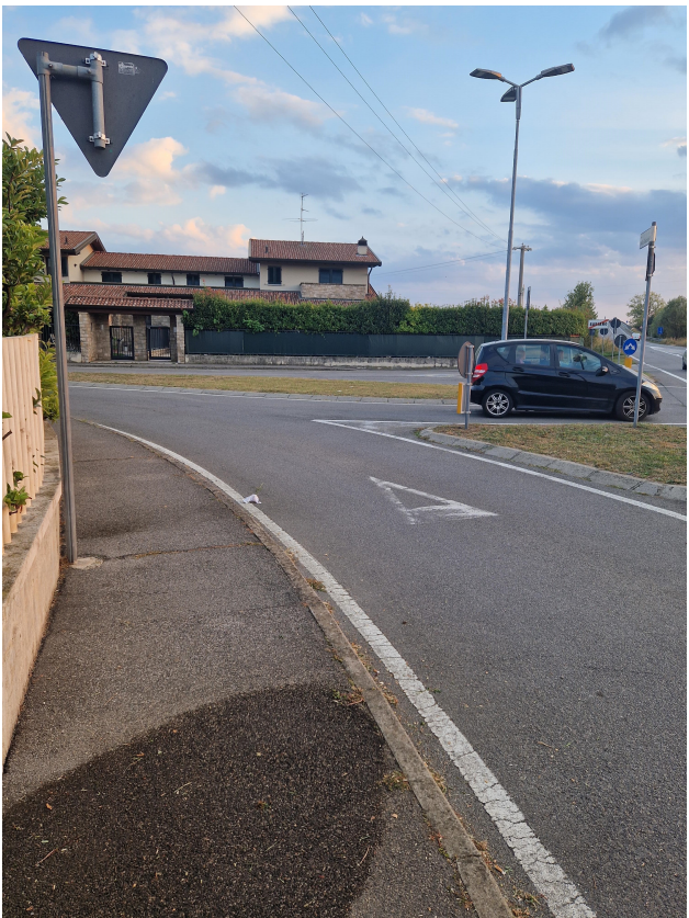
RISAGOMATURA DELL'ENTRATA IN VIA DELLA CASCINETTA
