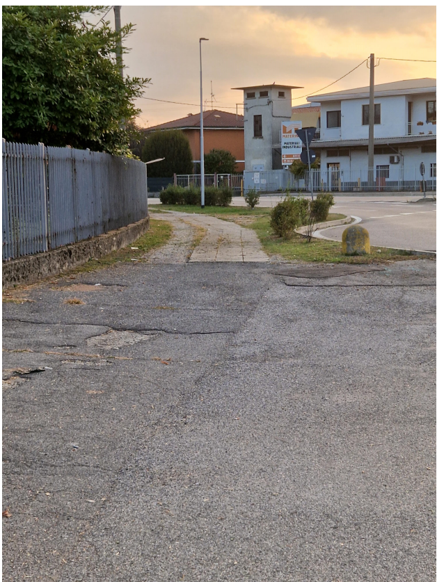
REALIZZAZIONE DELLA CICLABILE
