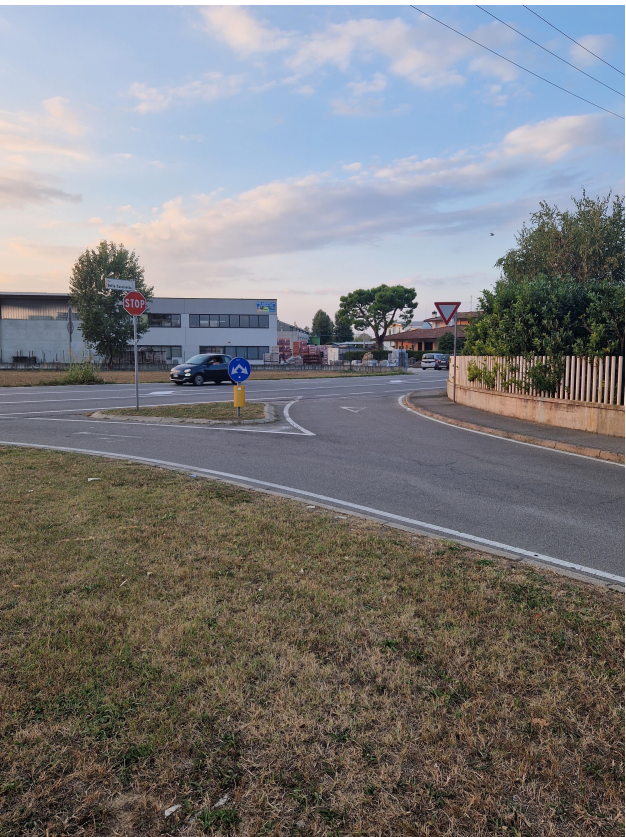
RISAGOMATURA DELL'USCITA IN VIA DELLA CASCINETTA
