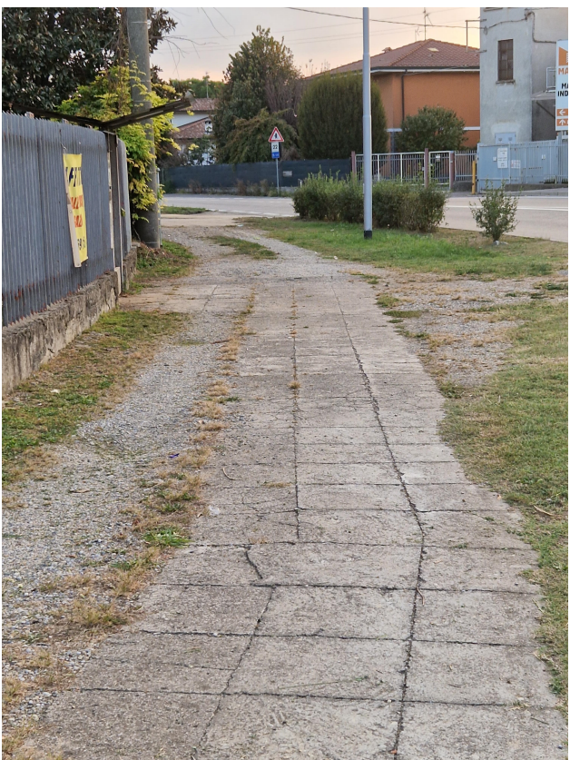
REALIZZAZIONE DELLA CICLABILE
