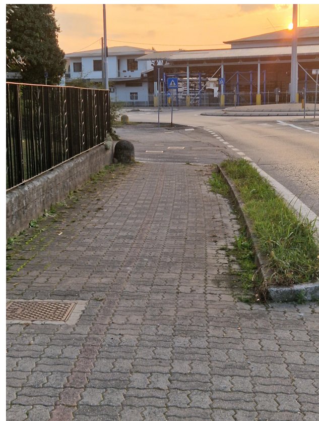
RIQUALIFICAZIONE AIUOLA DI DISTACCO E POSA PROTEZIONE
