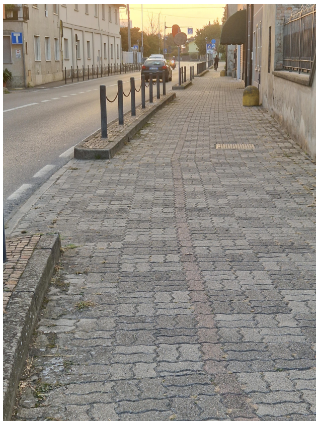
IL PAVIMENTO SI PRESENTA IN BUONO STATO DI COMPLANARITA'
