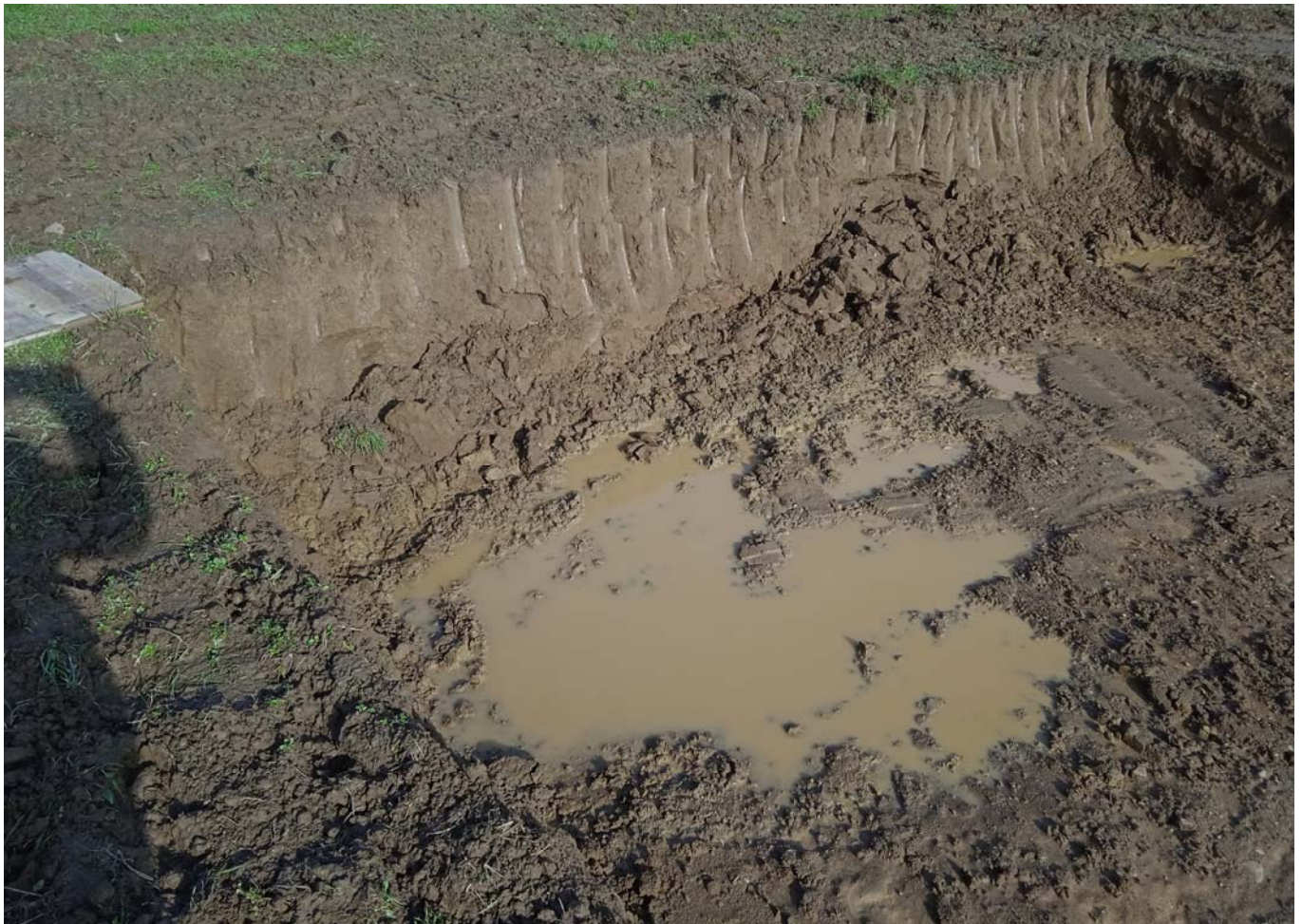
Figura 6: vista del fronte nord dello scavo alla data del 18 gennaio 2024 eseguito per la posa della gru nell'area del nuovo asilo nido.
