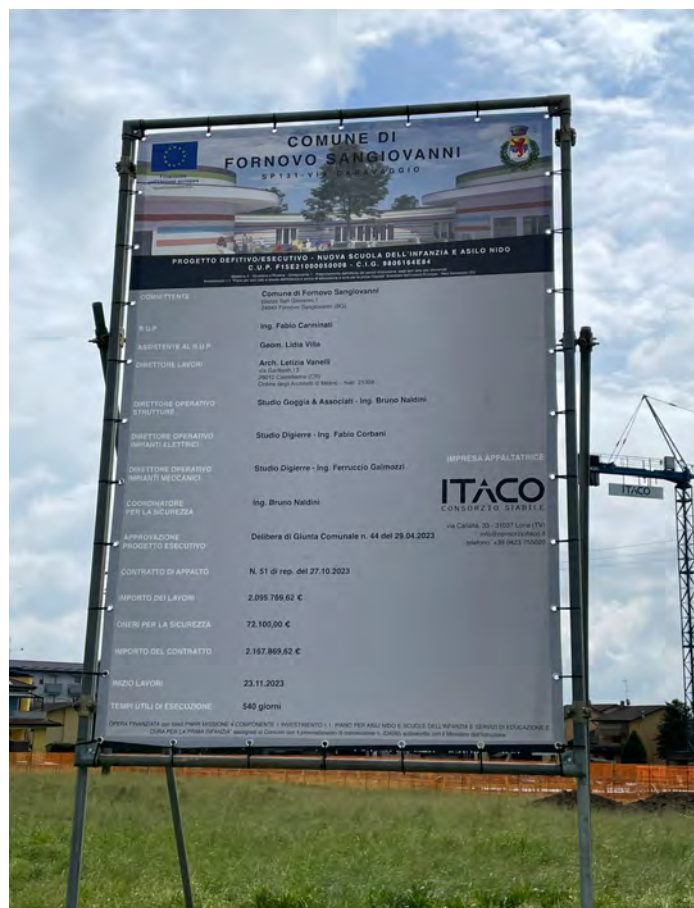
Foto - Cartello di cantiere per la realizzazione della Scuola dell'infanzia
